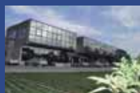
Ebara Pumps Europe S.p.A., ITÁLIA
